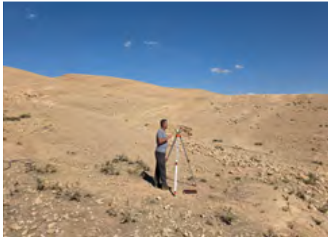
Vermessung der neuen Speicherteiche und Dämme an der Baumschule.
